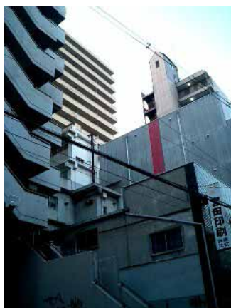
(マンションやビル)
